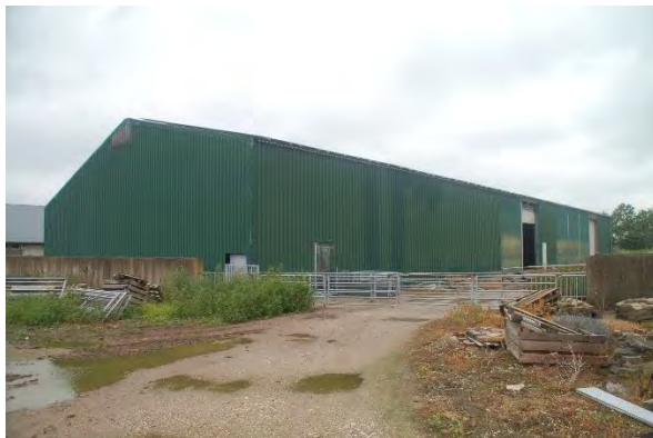
Afbeelding: loods achterzijde
