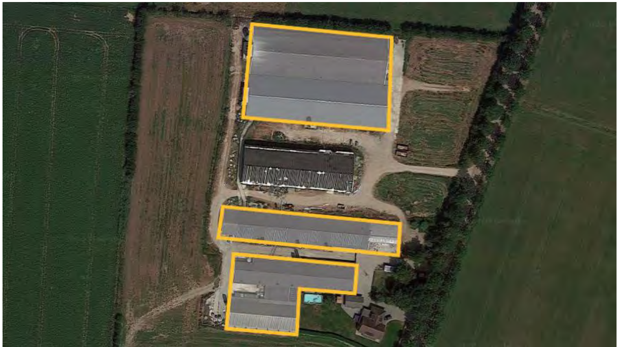
Afbeelding: de te slopen stallen bovenaanzicht
