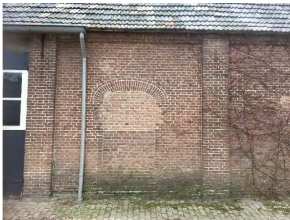
Dichtgezette mestdeur met verwijderd stalraam in zesde travee
