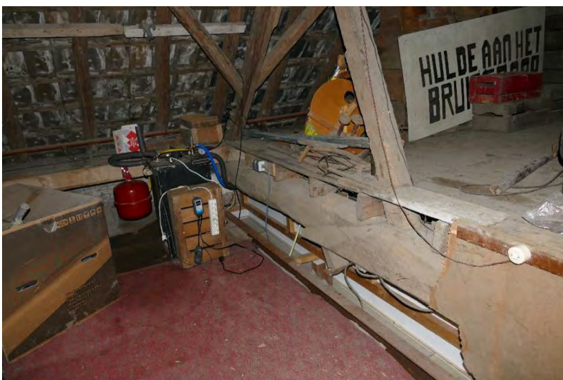
Kapconstructie boven de stal. Elk spant heeft een voetschoor.
