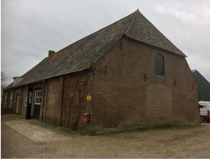
Oostelijke zijgevel en eindgevel. Voor het stalgedeelte ligt de betonnen gierkelder
