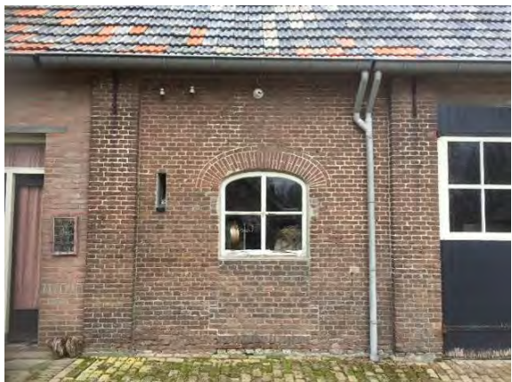
De dichtgezette mestdeur met toegevoegd stalraam in de vierde travee
