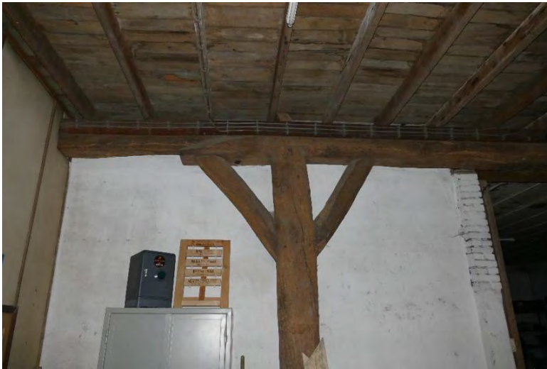
Standvink onder de ligger. Deze heeft een aangelengd deel dat op de penant in de gevel rust.
