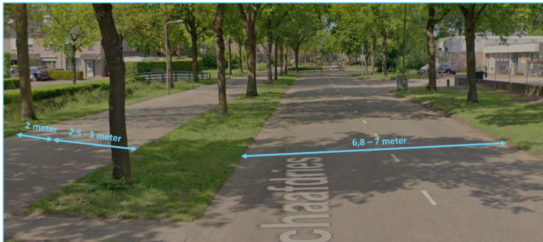
Figuur 4-4: Wegprofiel Schaafdries
