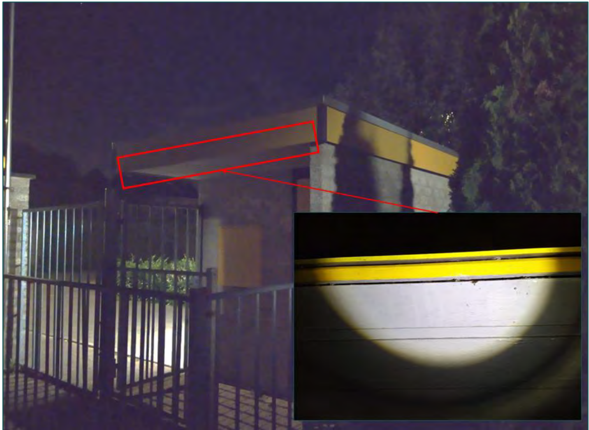
Figuur 3.26 Visuele weergave van de gebruikte opening van de paarverblijfplaats gewone dwergvleermuis vleermuisverblijfplaats achter de daklijst van het toegangskloket aan de Dorskamp 40.
