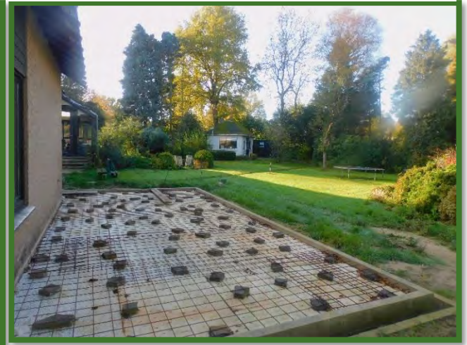
overzichtsfoto tuin en nieuwe aanbouw
