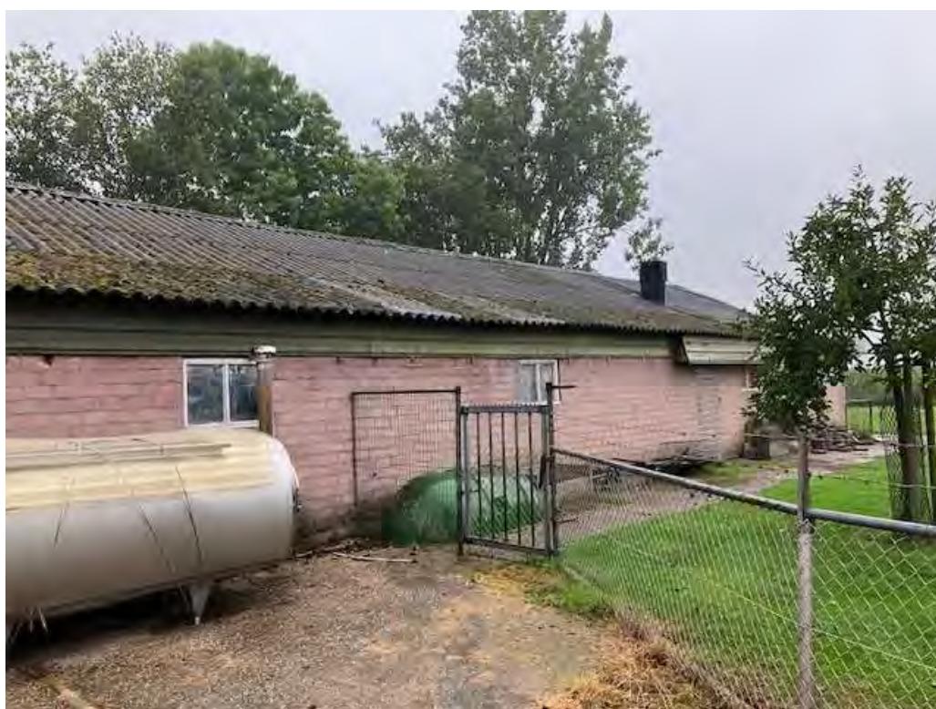
• Afbeelding 10: Zijgevel stal, ventilatieopening dicht geschroefd en voorzien van vogelschroot
