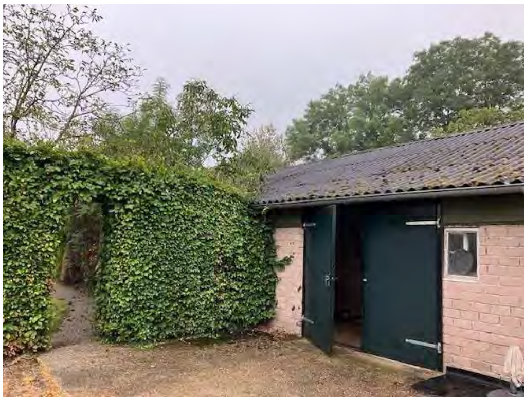
• Afbeelding 11: Deuren in de zijgevel gemaakt
