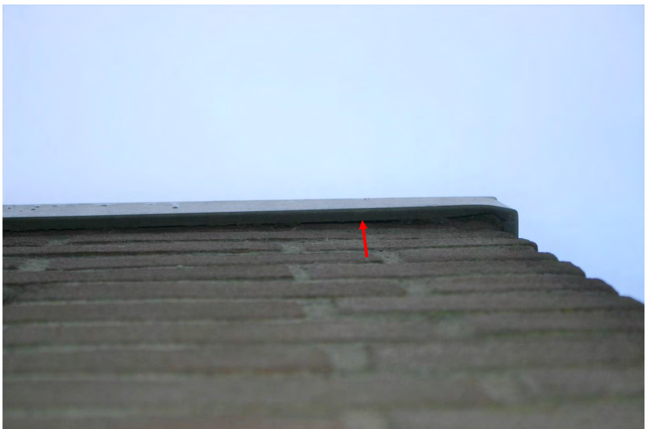
Figuur 4.4.3. Op meerdere plekken kiert de daktrim met de gevel (rode pijl), waardoor vleermuizen de bebouwing in kunnen.
