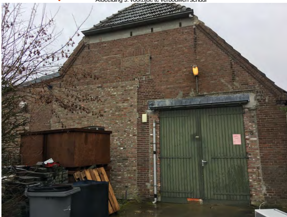
• Afbeelding 9: voorzijde te verbouwen schuur
