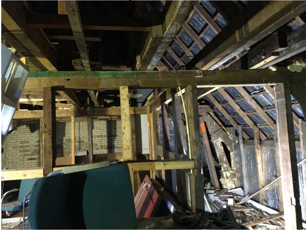
• Afbeelding 17: binnenzijde te zolderr
