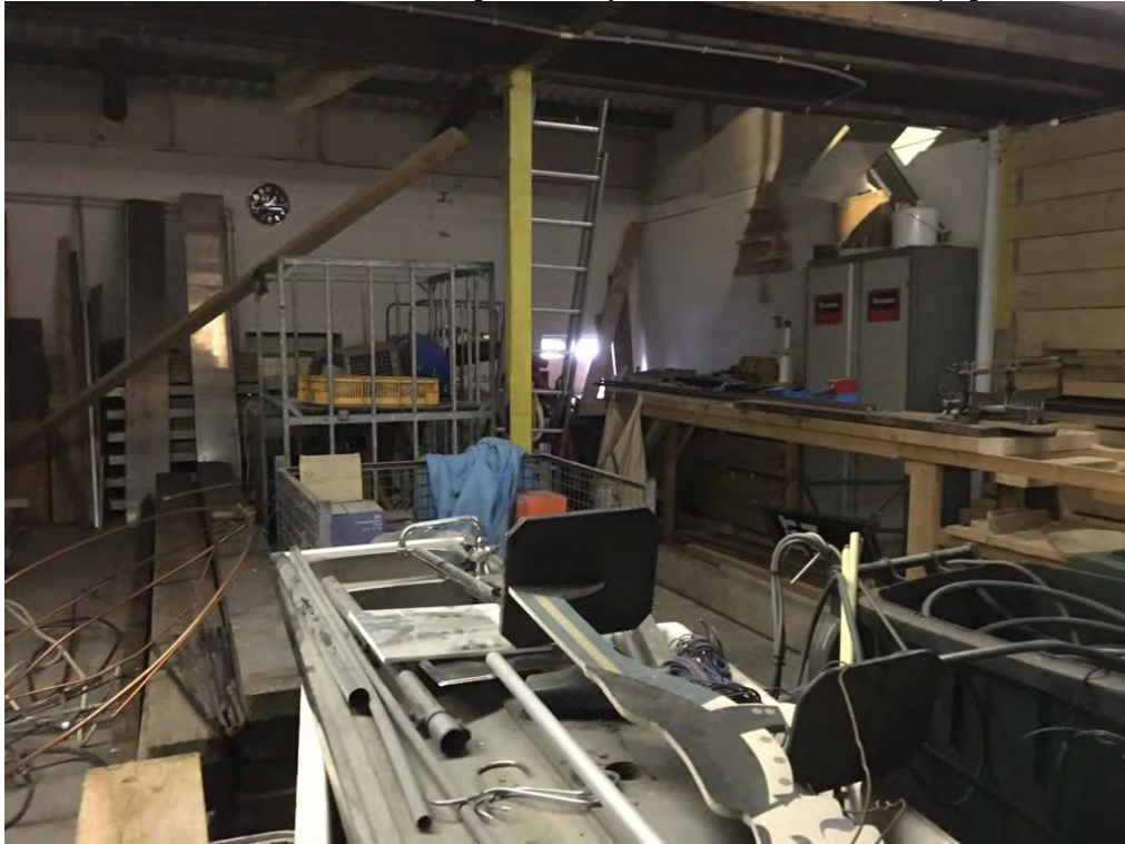
• Afbeelding 11: binnenzijde te verbouwen beneden verdieping schuur
