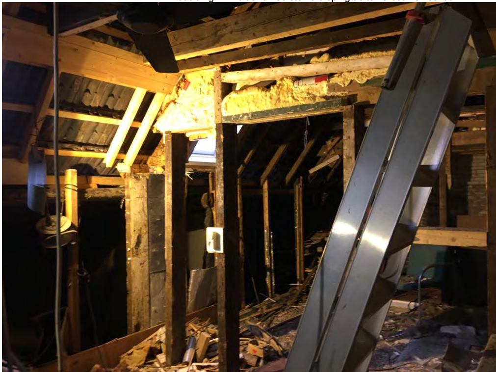
• Afbeelding 12: zolder en eerste verdieping de te verbouwen schuur
