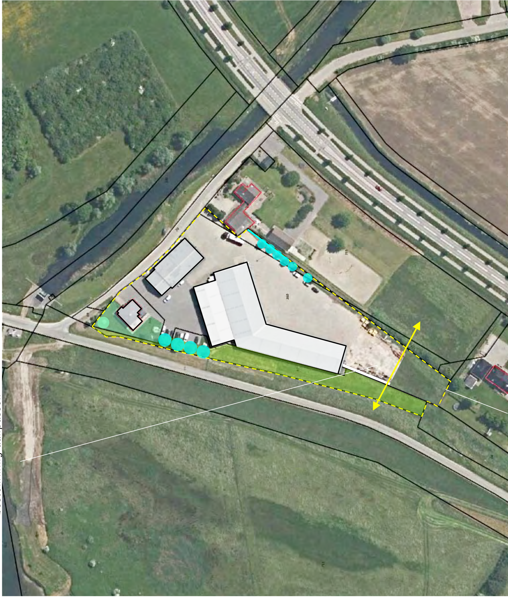
muren en verharding verwijderen; realiseren van beplanting
