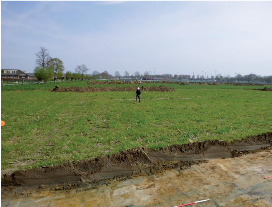
Afb. 2.8 Opname van de werkzaamheden tijdens het veldwerk; gezien naar het zuidoosten.
