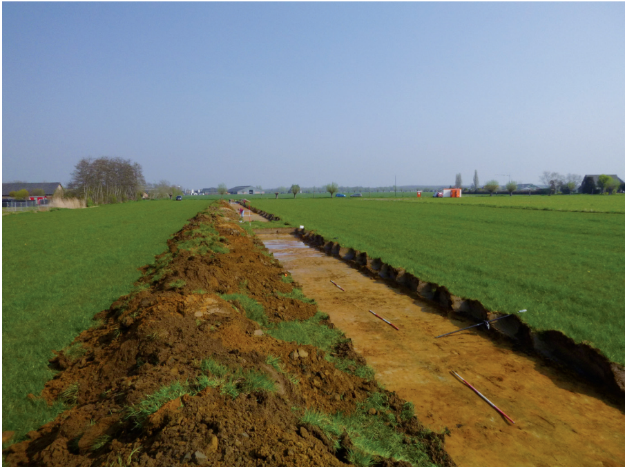
Afb. 3.3 Zicht op de aangelegde werkputten 4 en 5 gezien vanuit het zuiden kijkende in noordelijke richting (d.d. 08-04-2019). Binnen de lager gelegen geulzone komt het grondwater nagenoeg direct onder en zelfs lokaal binnen het aangelegde vlak voor.
