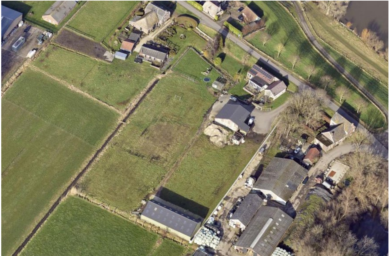
Figuur 4: Erf na de sloop van de stallen (2022)
