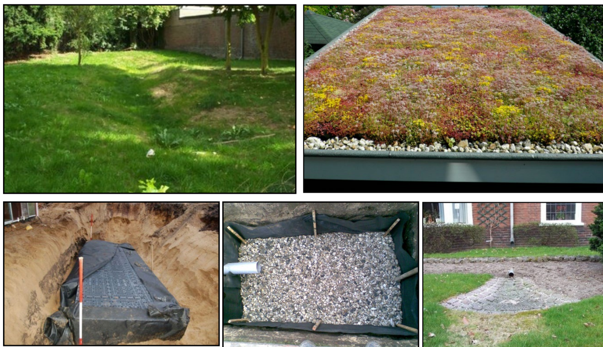
Figuur 13: Voorbeelden infiltratievoorzieningen
