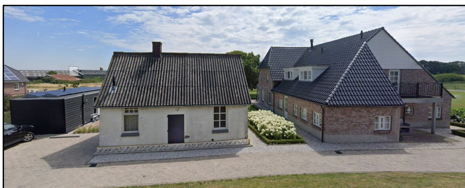
Afbeelding 5: weergave Oijense Benedendijk nr. 58 en 60 (jul. 2022) vanaf westelijke richting, nr. 2 op luchtfoto (bron: Google Maps)
