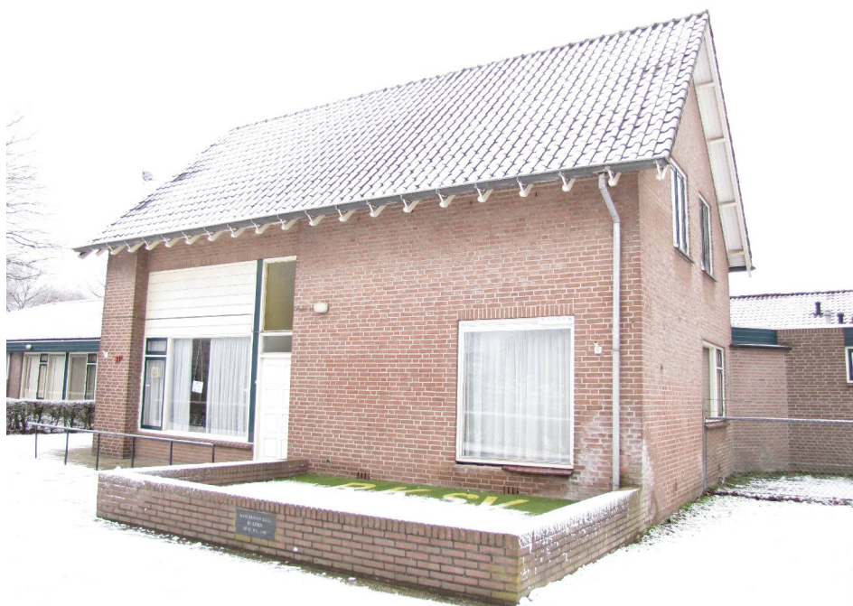
Figuur 1: Te slopen pand
