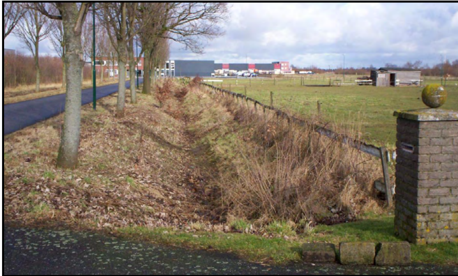
Figuur 4: bermsloot parallel aan de Nieuwesteeg
