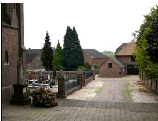
locatie vanaf het kerkplein
