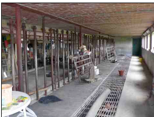
In- en exterieur oude rundveestal
