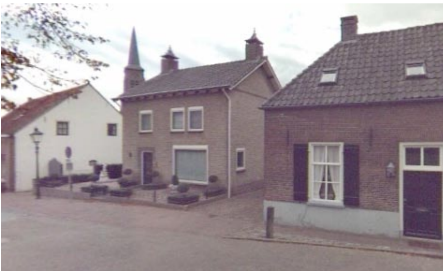
overgang met Verlengde Torenstraat 5
