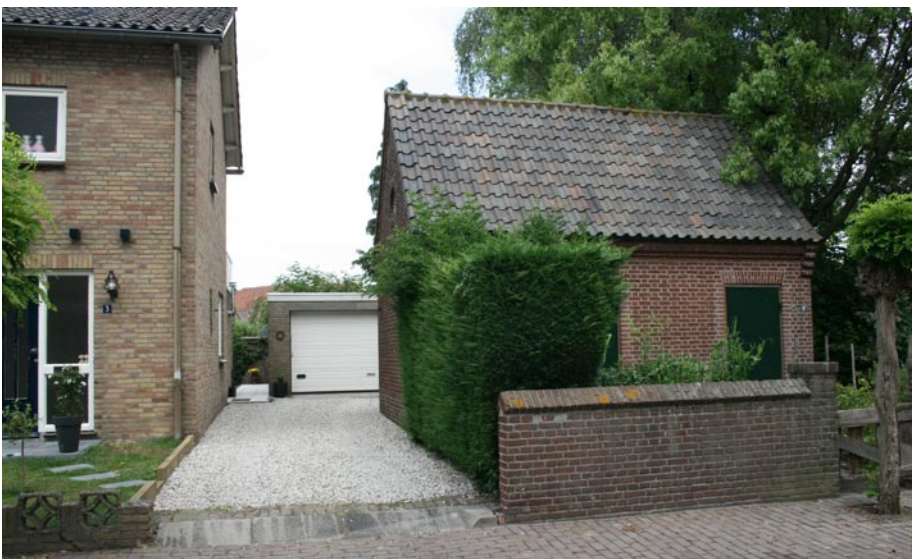
overgang met nutsgebouwtje
