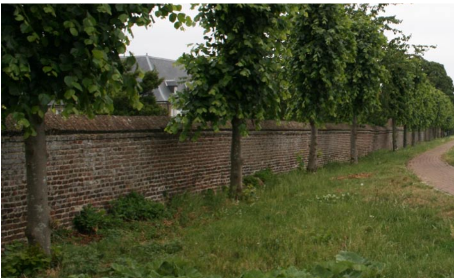
muur kloostertuin vanaf zuid- zijde
