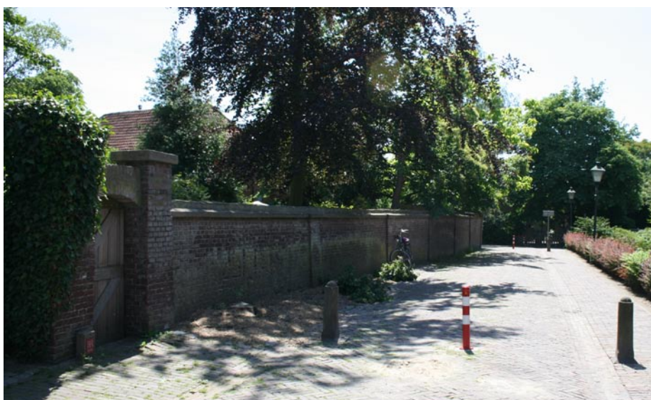
overgang op ommuurde achtertuinen Willem Kippstraat 6-8
