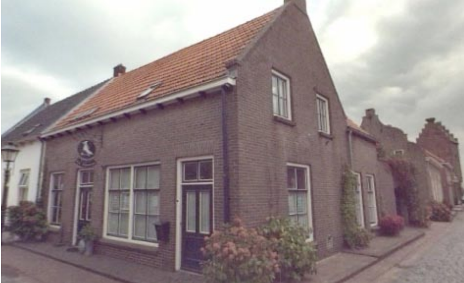
hoek Torenstraat - Kloosterstraat
