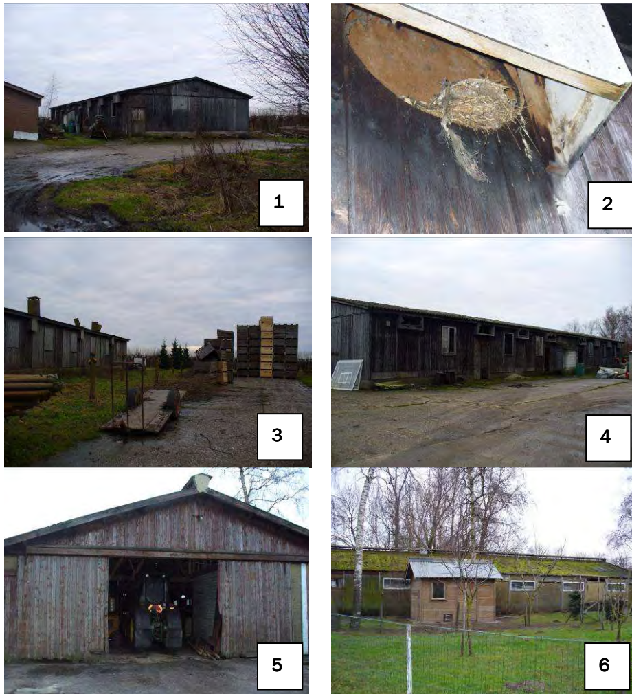
Figuur 3a: Impressie plangebied Rosmolenstraat. 1: te slopen westelijke schuur, 2: nest in te slopen schuur, 3: zijkant schuur en kratten, 4: oostzijde schuur, 5: vooraanzicht noordelijke schuur, 6: zij-aanzicht noordelijke schuur (Croonen Adviseurs, 2011)
