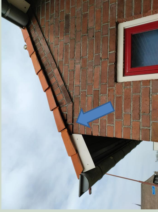
Potentiële holte (vleermuis, huismus, gierzwaluw)
