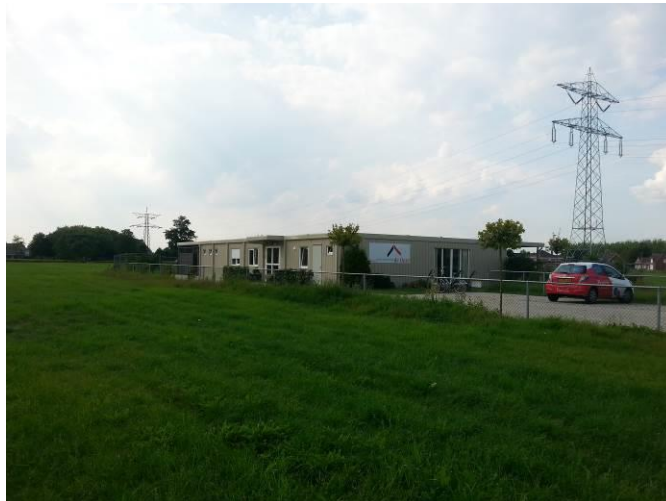
Foto 2: Gebouwtje aanwezig op het terrein.
