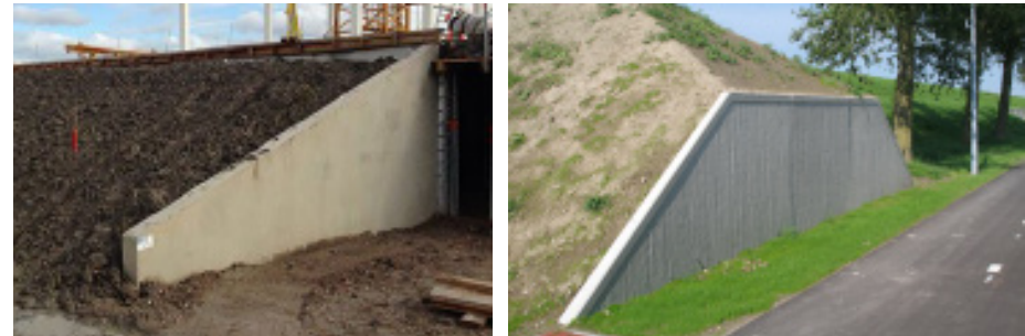
Er wordt aangesloten op het reliëf van het maaiveld
