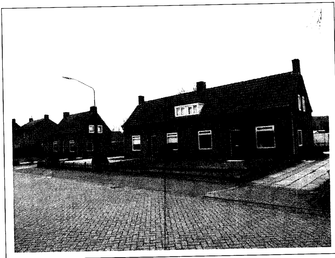
Foto 1. De te slopen woningen (v.l.n.r. 5-3-1) gezien van de Groenstraat.
