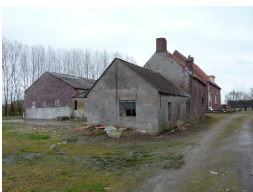
Te behouden bakhuisje met daaromheen de te slopen schuren en veestallen
