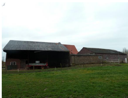
De te slopen kapschuur en veestal
