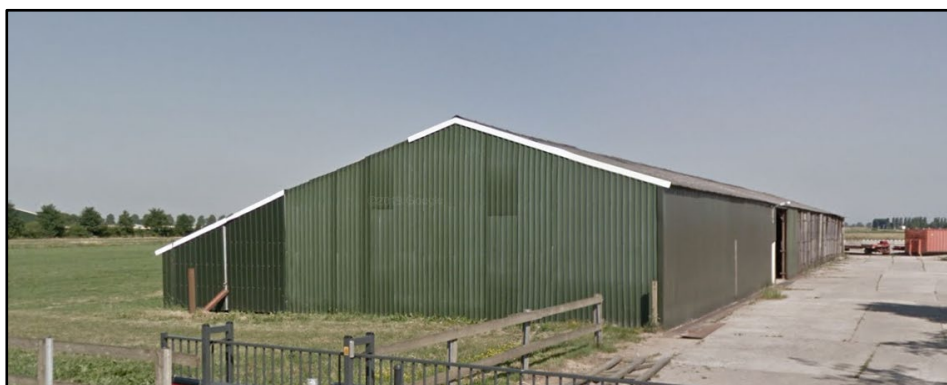
Afbeelding 7: foto van één van de verouderde bedrijfsgebouwen (bron: Google Street View)
