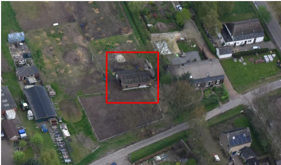
TE SLOPEN BEBOUWING
