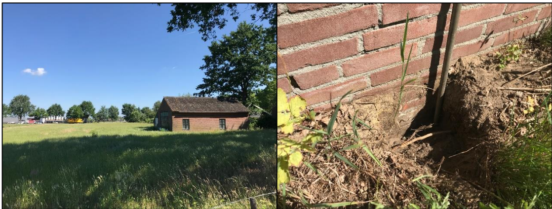
Figuur 9. Links: impressie van het plangebied, foto genomen richting het noordwesten. Rechts is een foto van de fundering, waar bij te zien is tot hoe diep deze ongeveer reikt. De foto's zijn genomen tijdens het veldonderzoek op 17-06-2019. Fotograaf: T. Nales.
