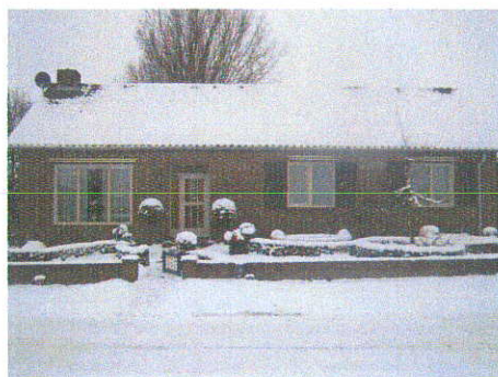
Pastoor van Weerdstraat 3, woning
