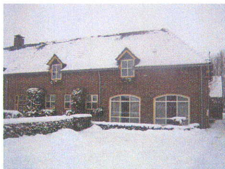
Pastoor van Weerdstraat 5, woning
