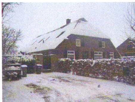
Pastoor van Weerdstraat 8, woning
