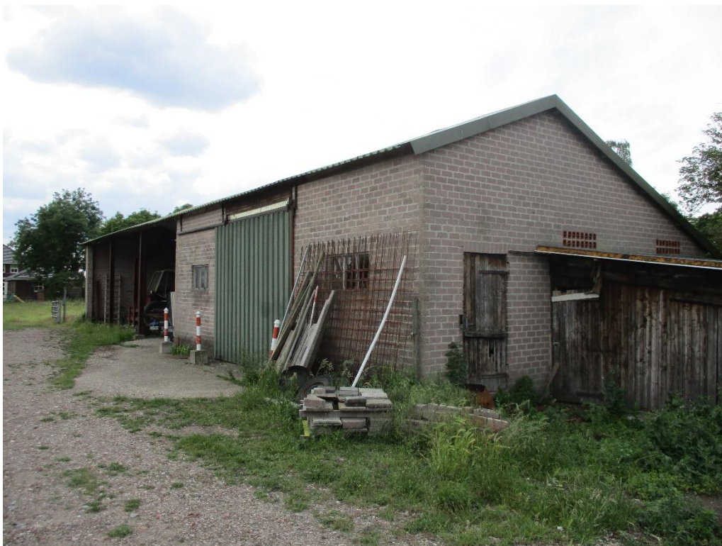
Figuur 2 De schuur gelegen in het plangebied is opgetrokken uit gemetselde muren zonder spouw en zadeldak met damwandplaten.
