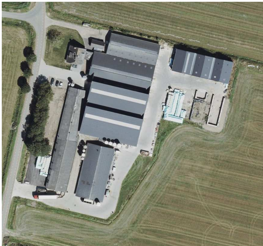
Afbeelding 1: luchtfoto projectlocatie Hertog Janstraat 52 te Lith (bron: Cyclomedia)
