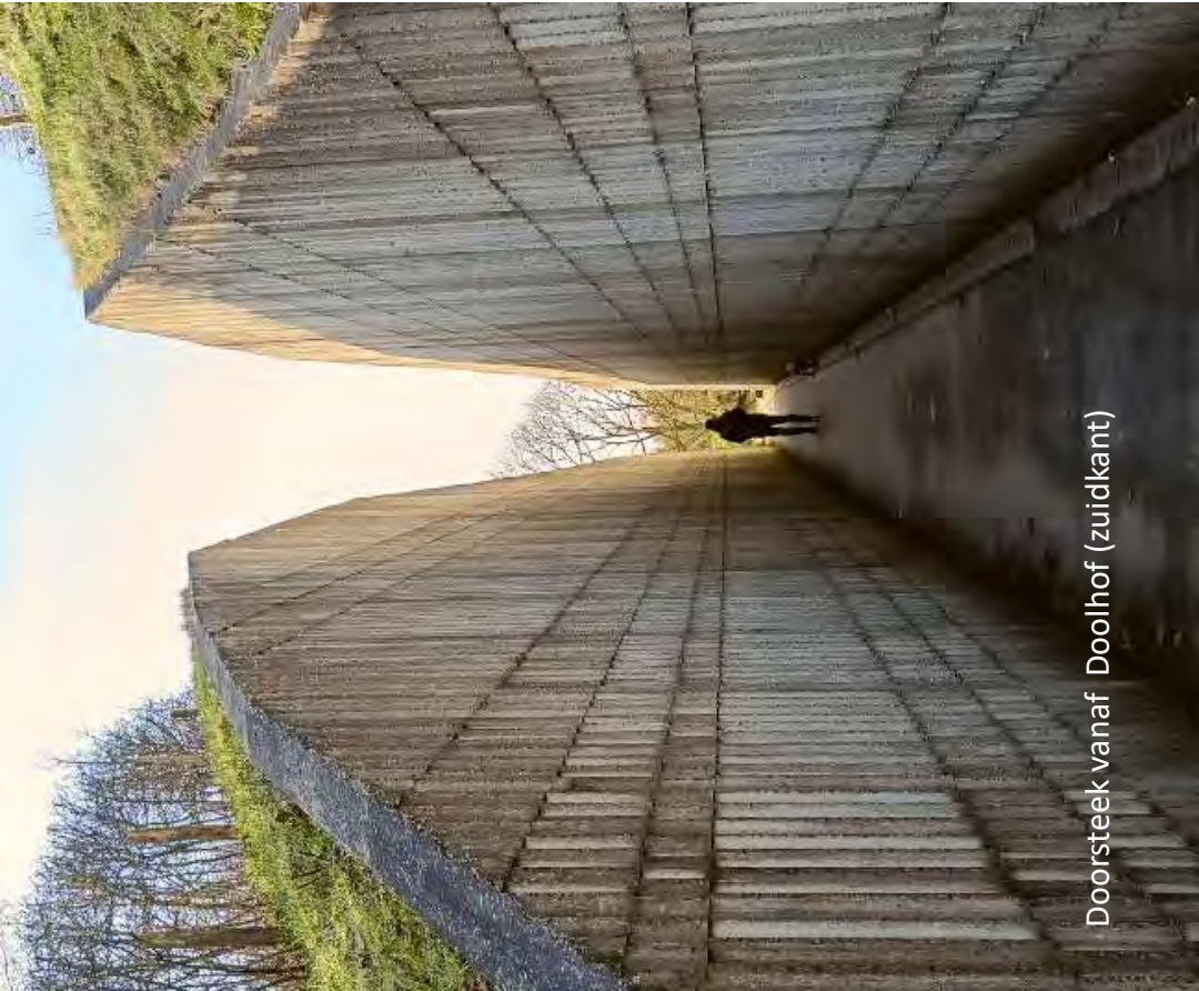
Grastalud op gebouw / gebouw in grondlichaam
