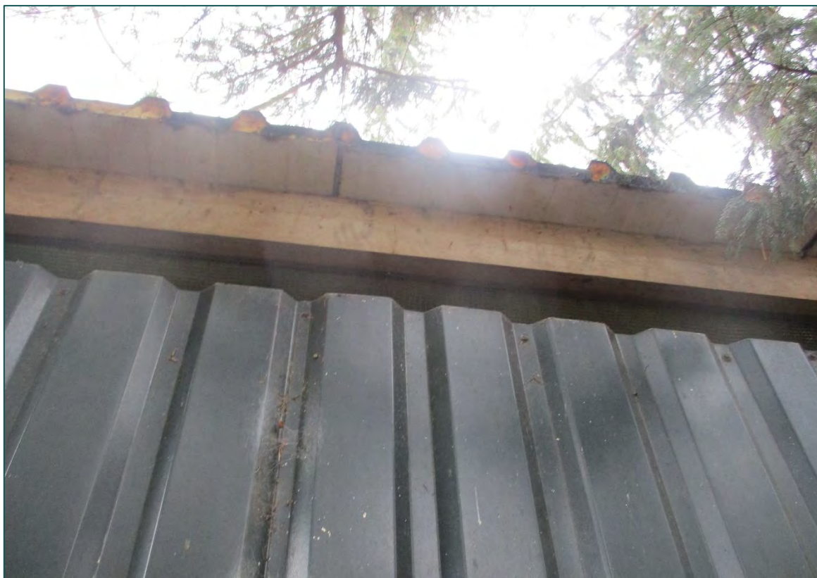
Figuur 2 De loods (b.) heeft tussen de damwandplaten gaas.
