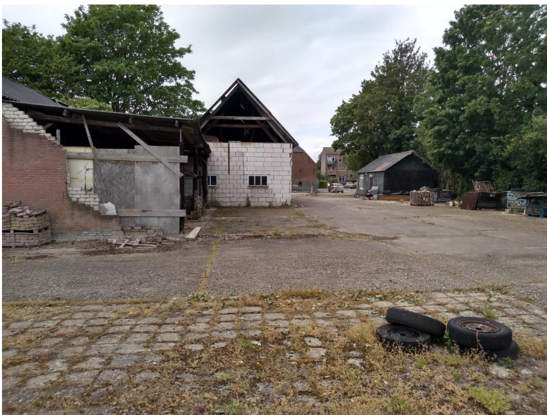
Afbeelding 17: Foto van noordelijk deel van het plangebied (het erf). Foto in westelijke richting.
