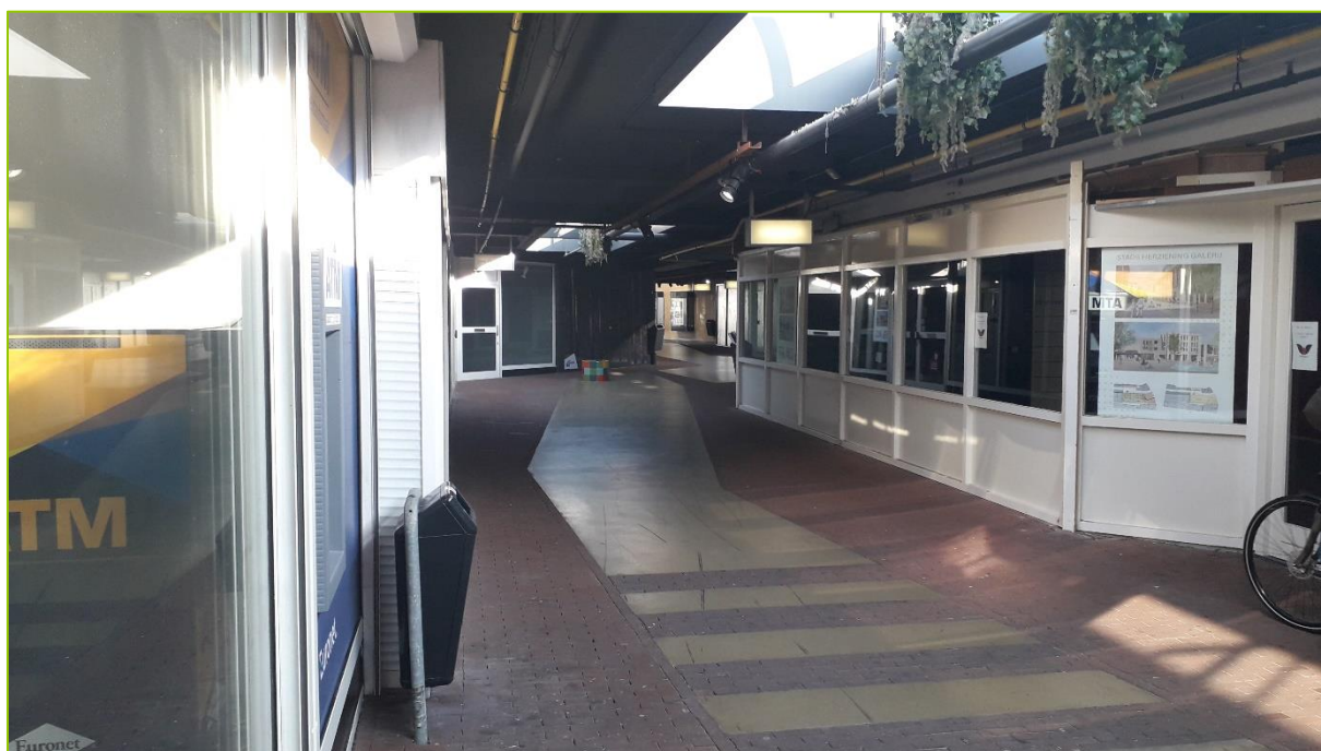
De ontwikkeling betreft het saneren van een deel van het complex, waarbij meer woongelegenheid gecreëerd zal worden
