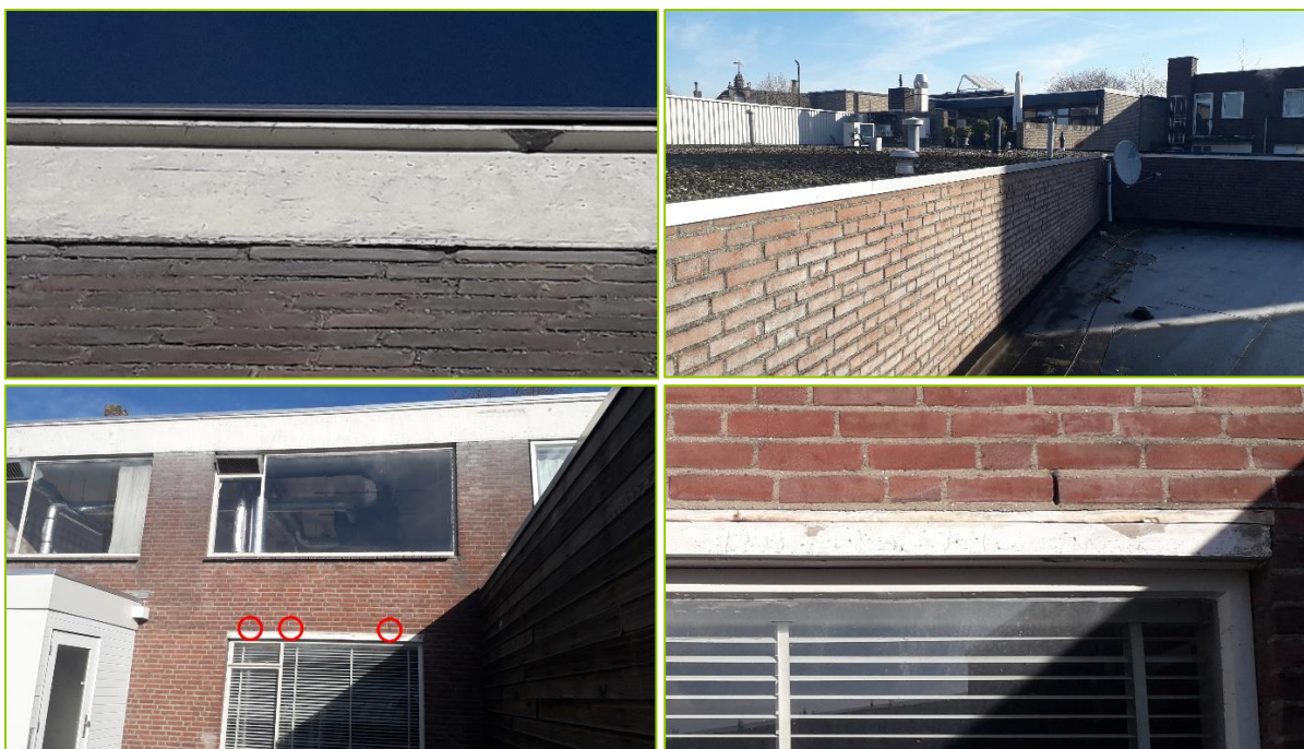
Figuur 2 Detailfoto's van de te slopen bebouwing
