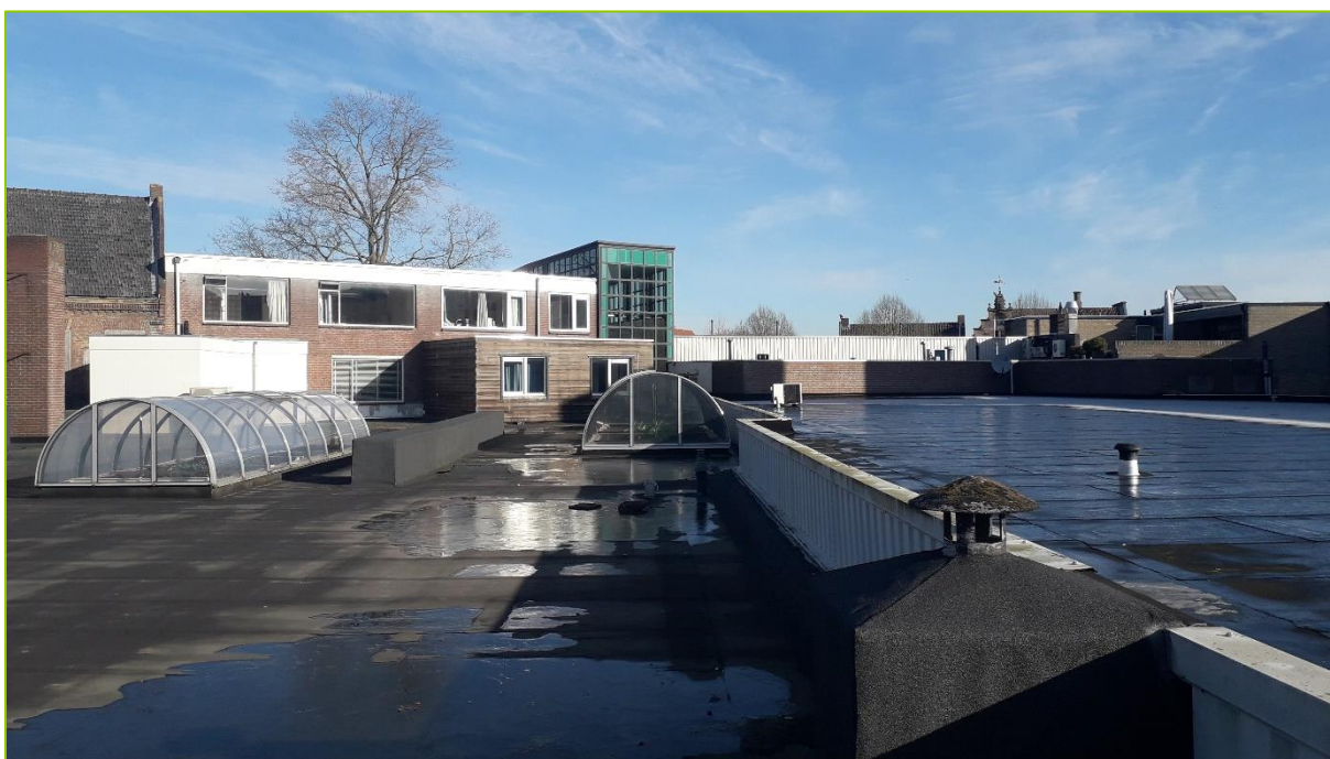
Het dak bestaat met name uit bitumen dat voor een klein deel is afgedekt met grind.
