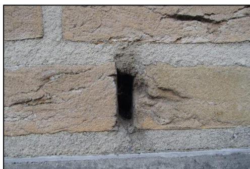
Voorbeeld van open stootvoeg in het plangebied.
