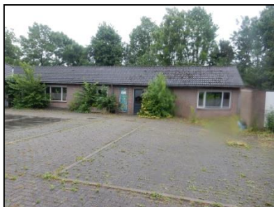
Figuur 4. Achterzijde brandweerkazerne.
