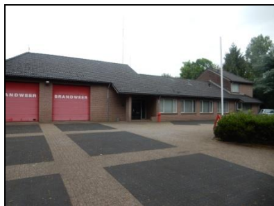
Figuur 3. Voorzijde brandweerkazerne met woning.
