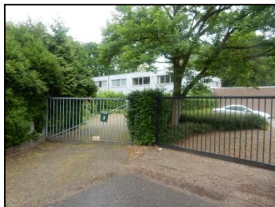
Figuur 7. Loods noord van westen onderzoekslocatie.
