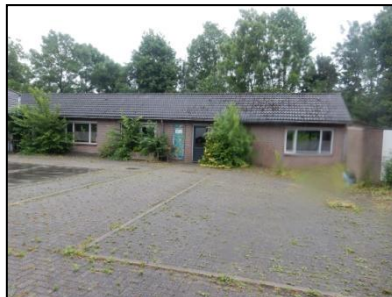
Figuur 4. Achterzijde brandweerkazerne.
