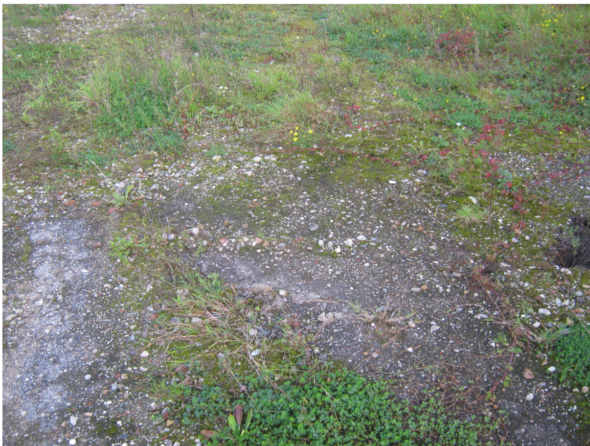
Foto 8: terreinverharding noordelijk terreindeel
