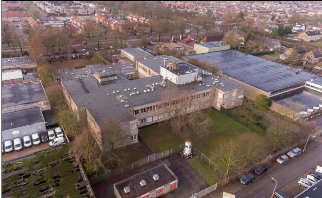
Figuur 2.6: Luchtfoto plangebied, gezien vanaf de zijde van de Sweelinckstraat (Bron: KCAP).
