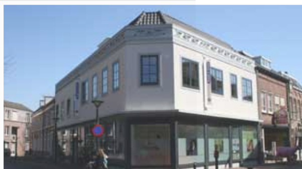
Gevelverbetering aan de Kerkstraat (2008 - 2009)
