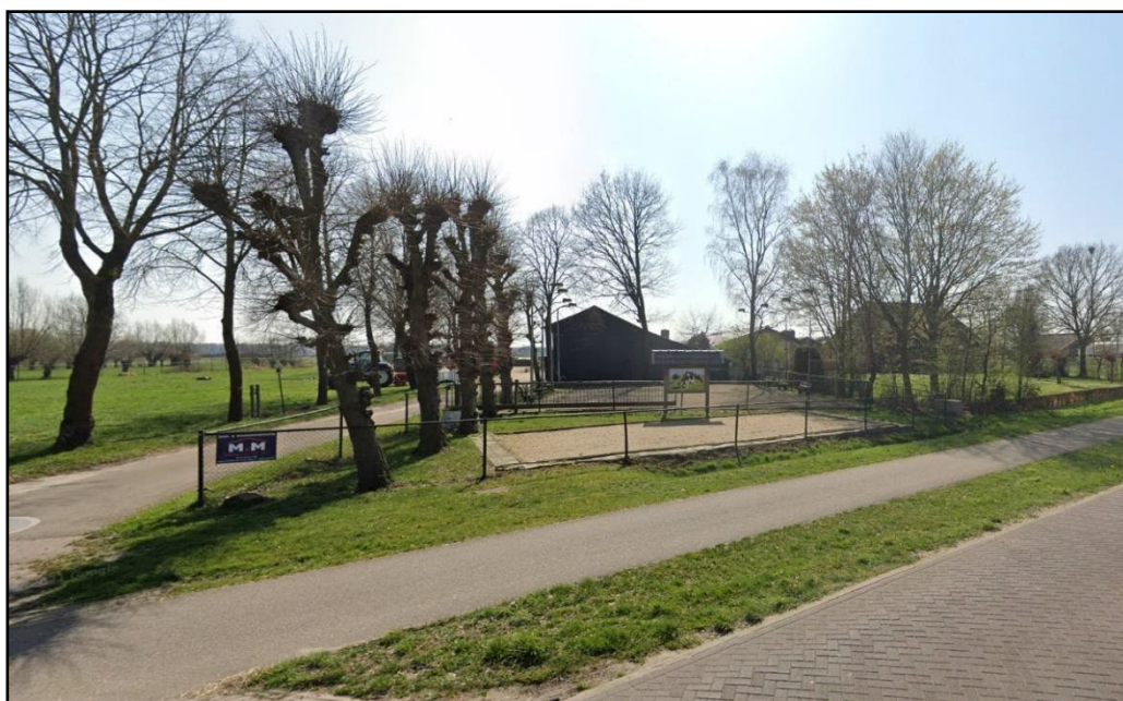
Afbeelding 3: Aanzicht vanaf Burg. van Erpstraat op bedrijfsoprit en de te slopen loods (bron: Google Street View)
