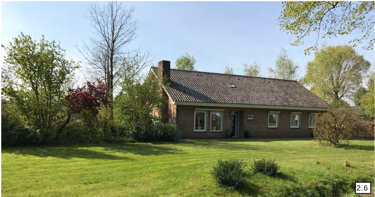
Figuur 2.6: Het woonhuis, gezien vanaf de Heistraat
