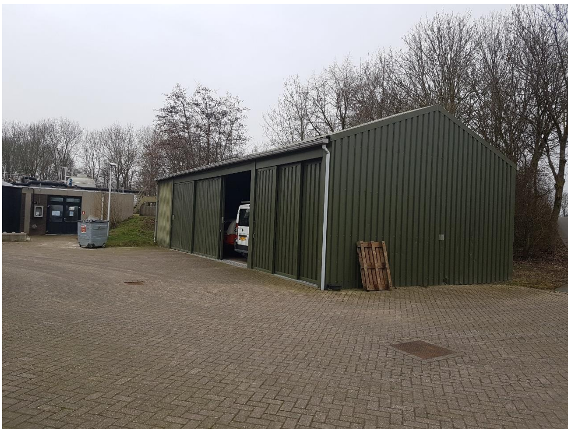
Type schuur dat wordt gebouwd
