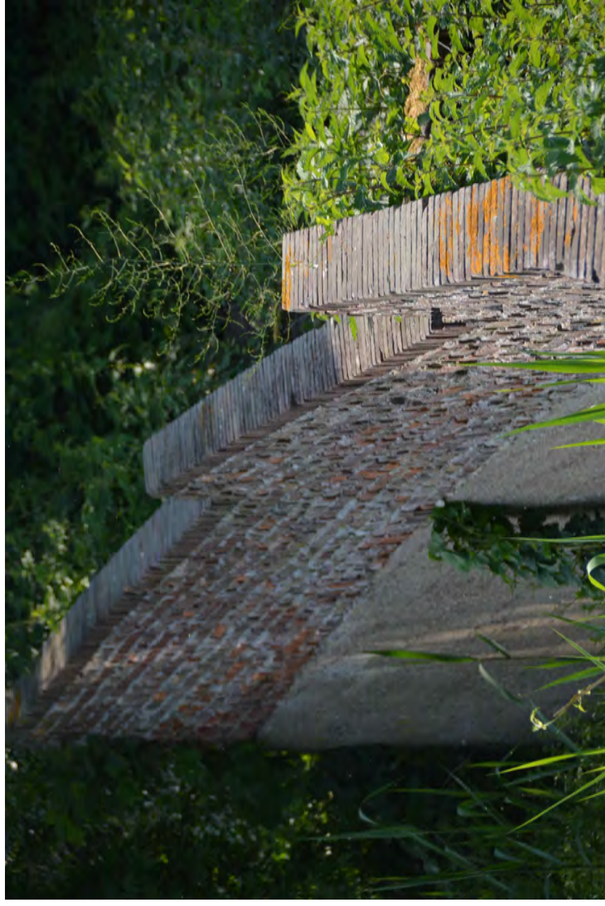
Bovenaanzicht keermuur zuidgevel
