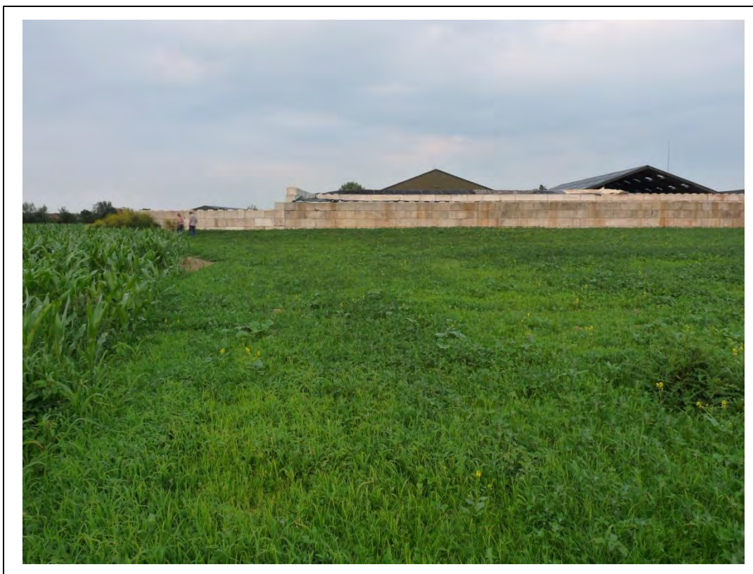
Foto 6. Sleufsilos gezien vanuit westelijke richting
