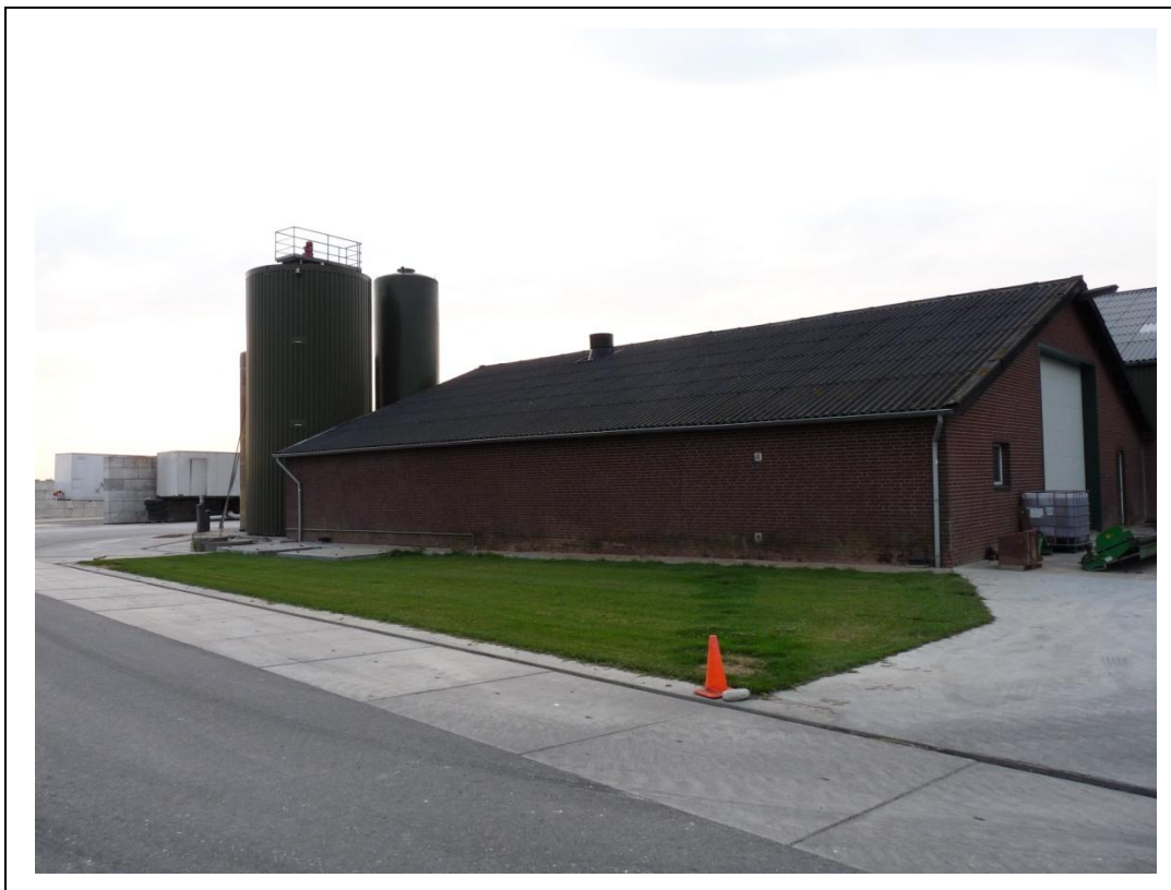
Foto 5. Westelijk gelegen loods
