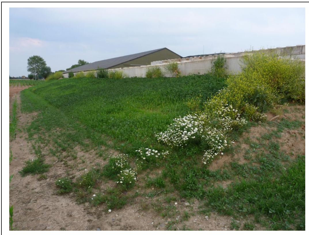
Foto 7. Talud tegen noordzijde sleufsilo's
