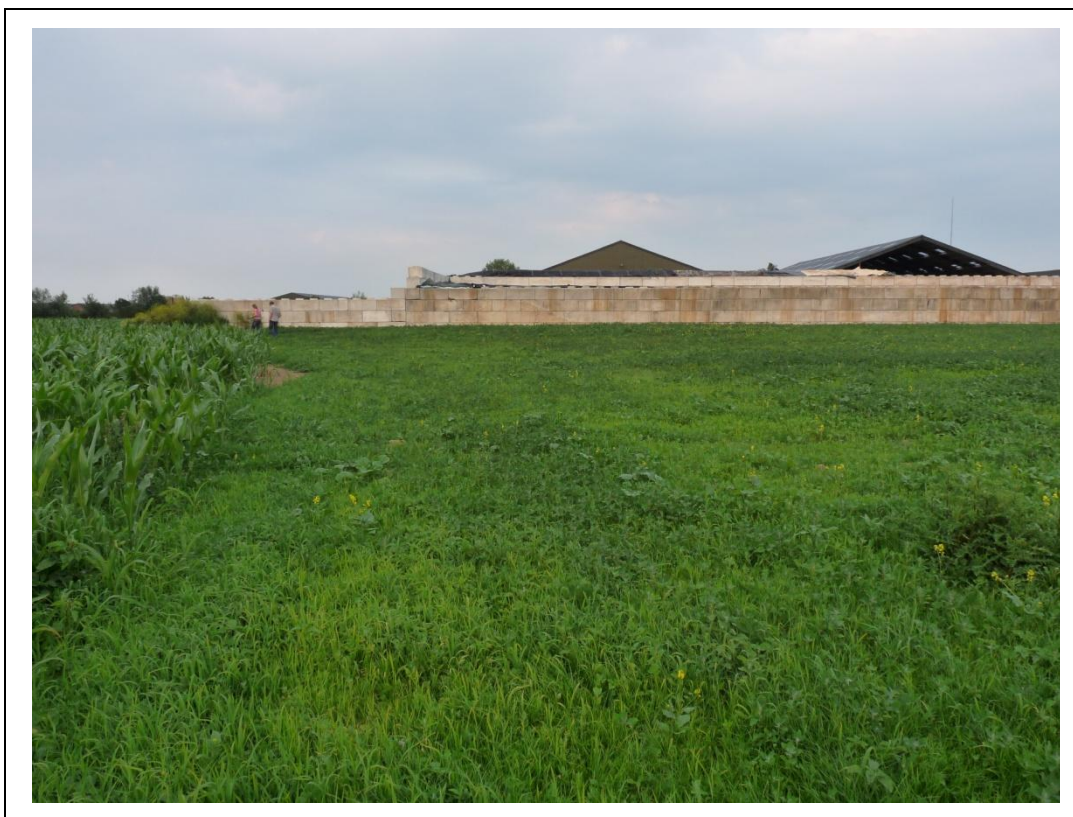
Foto 6. Sleufsilos gezien vanuit westelijke richting
