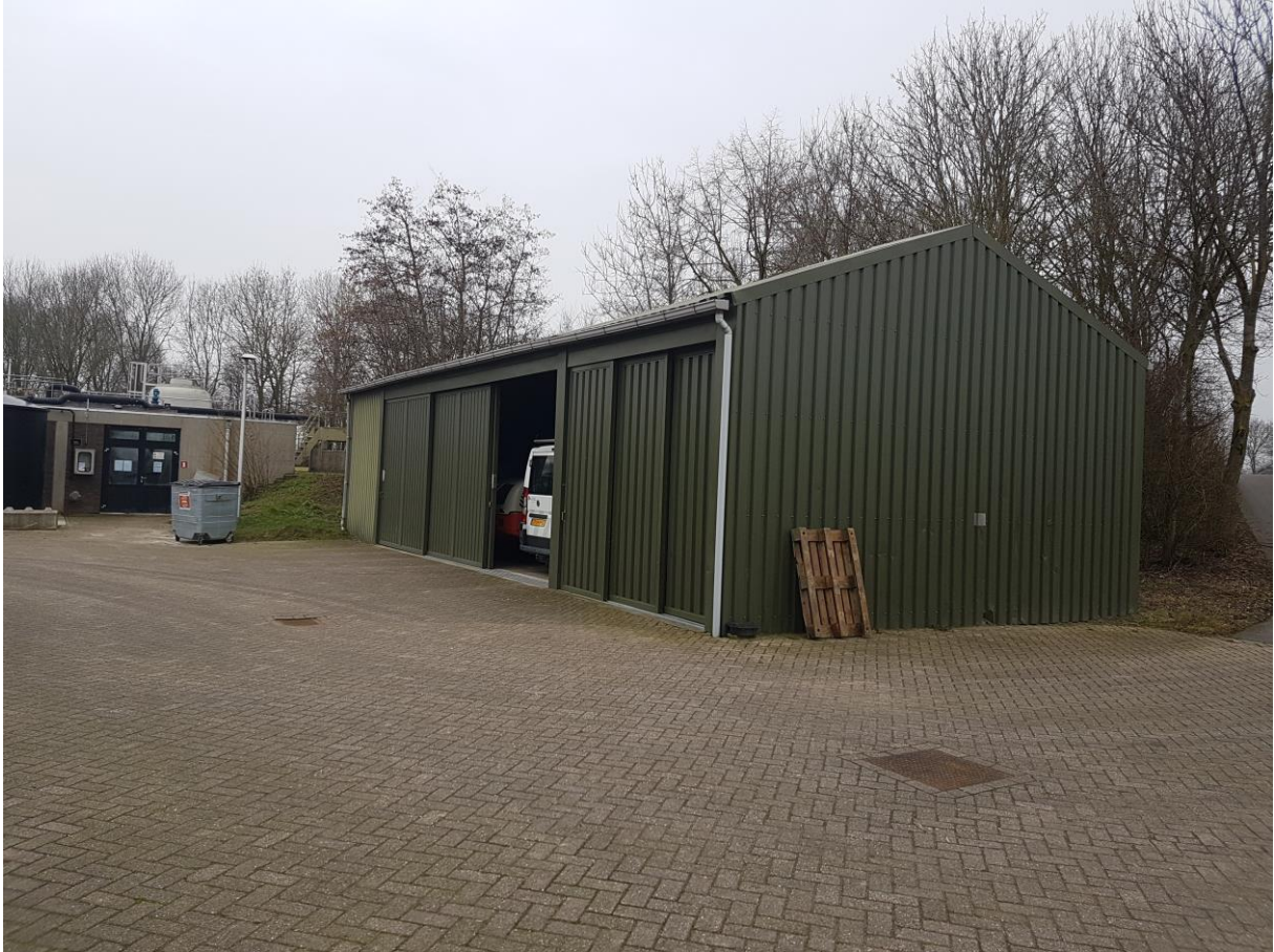
Figuur 7 Type loods dat wordt gebouwd
