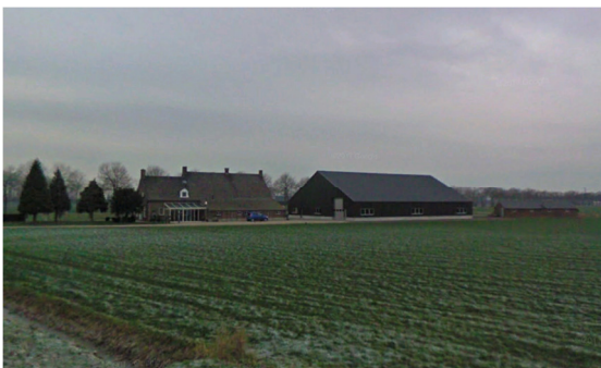
Fig. 2.1 Herstraat 5, oostelijke zijde
