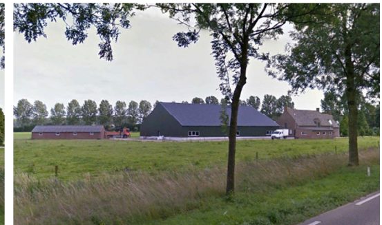
Fig. 2.2 Herstraat 5, noord-westelijke zijde
