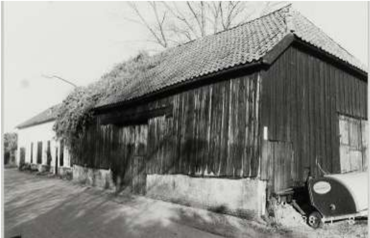
Oijense Benedendijk 7. Een langgevelboerderij met een nog grotendeels van houten wanden voorzien bedrijfsgedeelte met dwarsdeel. Situatie in 1988. (foto BHIC)
