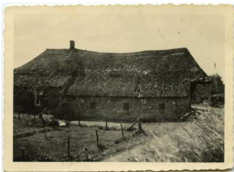
Een oude foto van Oijense Benedendijk 14, een kortgevelboerderij met overstek boven de achtergevel (BHIC)
