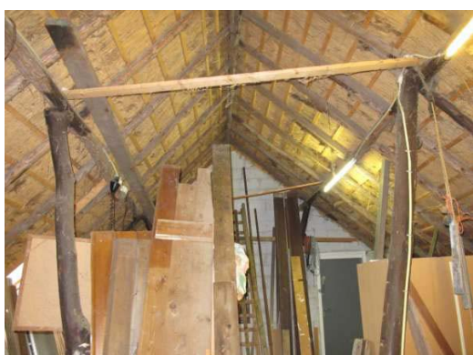
sporenkap op de zolder boven de deel
