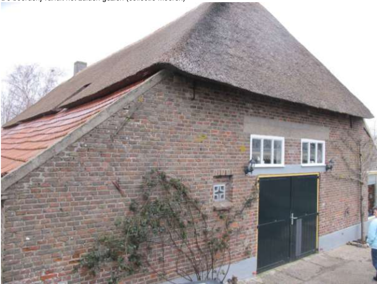
Overzicht achtergevel boerderij (FH MAB jan 2012)
