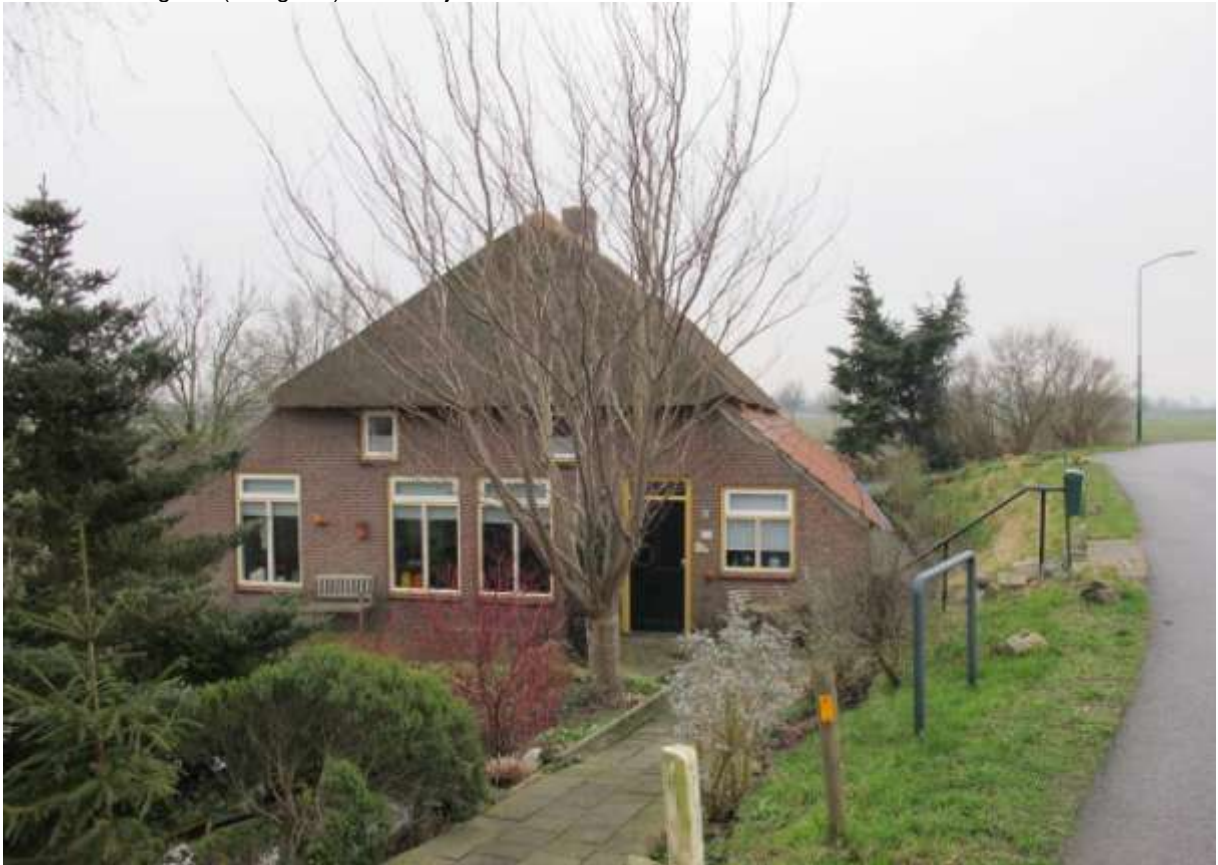
Zicht op de voorgevel vanaf de dijk. FH MAB jan 2012
