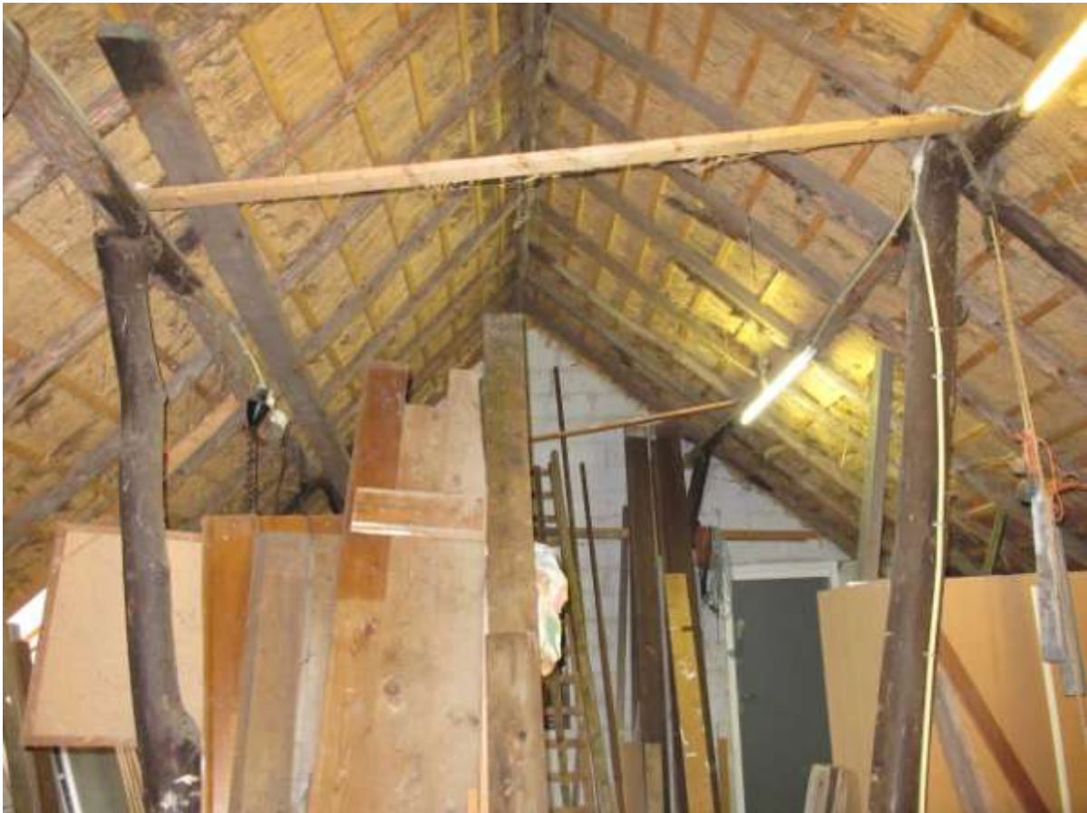
Zicht op de sporenkap op de zolder boven het voormalige bedrijfsgeboude. FH MAB 2012
