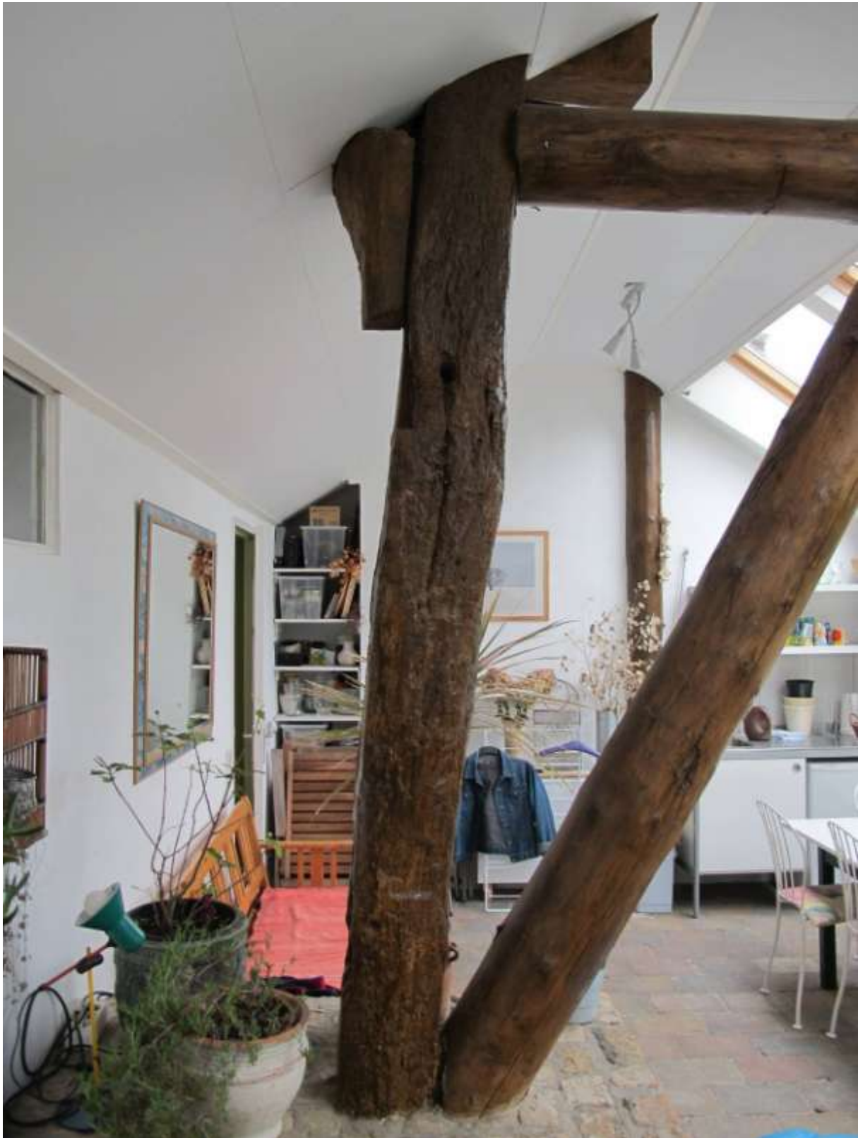
De zuidelijke gebintstijl van het westelijke gebint in de tuinkamer. De overige hier zichtbare balken zijn recent ingebracht bij de verbouwing van deze zijbeuk tot tuinkamer. FH MAB 2012
