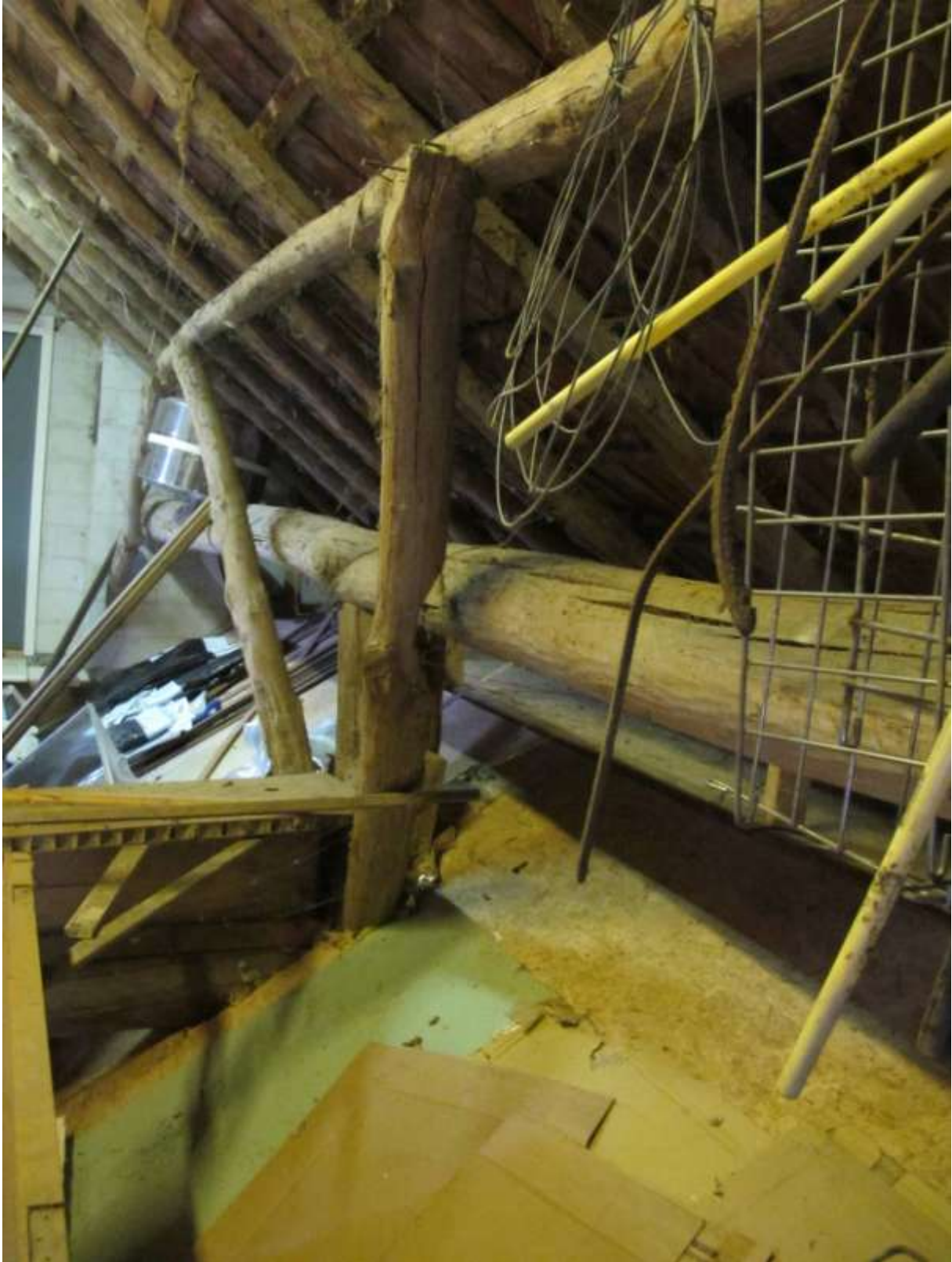
Het zuidelijke deel van het gebint op de zolder van het bedrijfsgedeelte. Let op de oude rondhouten plaat en de daarboven geplaatste jongere gebintplaat met schoren. FH MAB 2012
