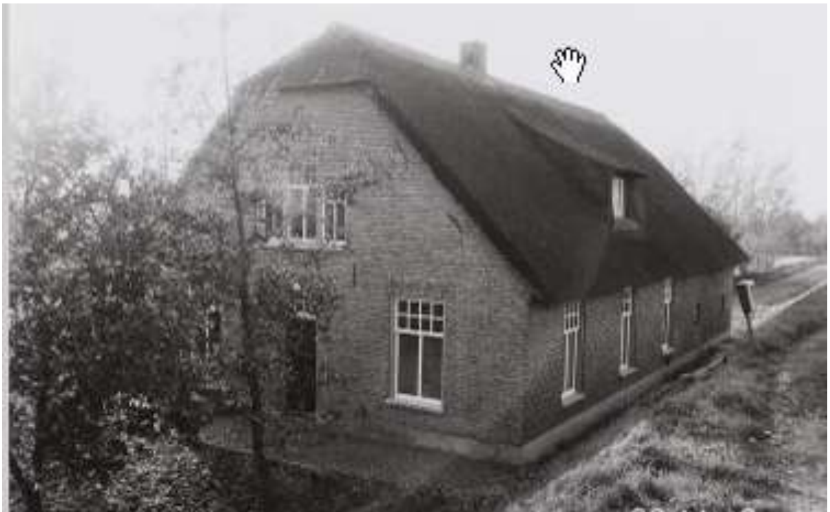
Oijense Benedendijk 20. Een jongere (1915-20) parallel aan de dijk gebouwde kortgevelboerderij . Situatie in 1988 (BHIC)
