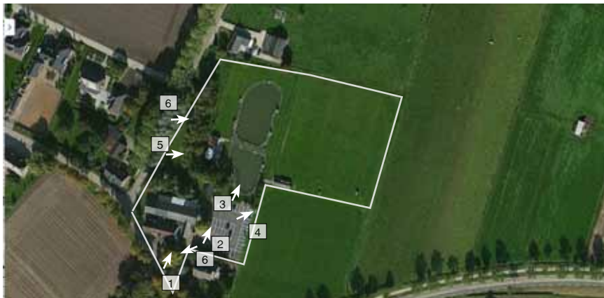
Figuur 5: Luchtfoto met aanduiding foto's
