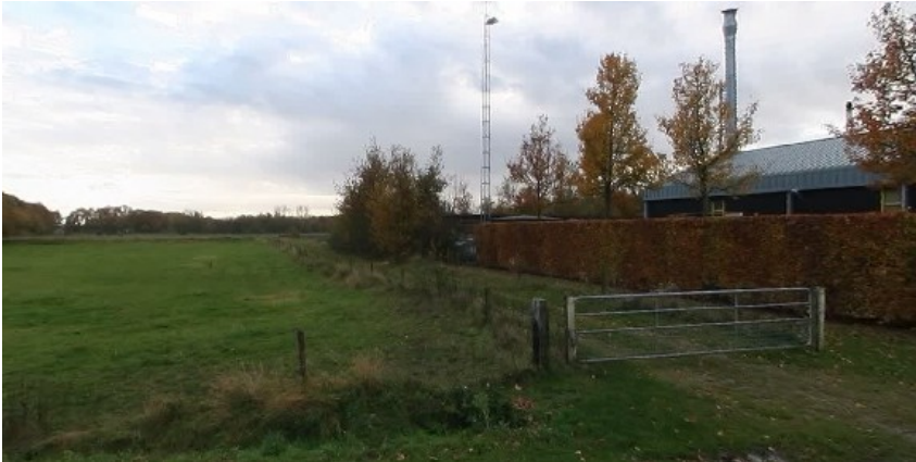
Afbeelding bestaande situatie, gezien vanaf de Molenstraat.
