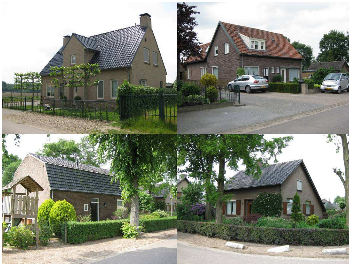
Figuur 7. Bebouwing aan de Rijnstraat te Herpen
