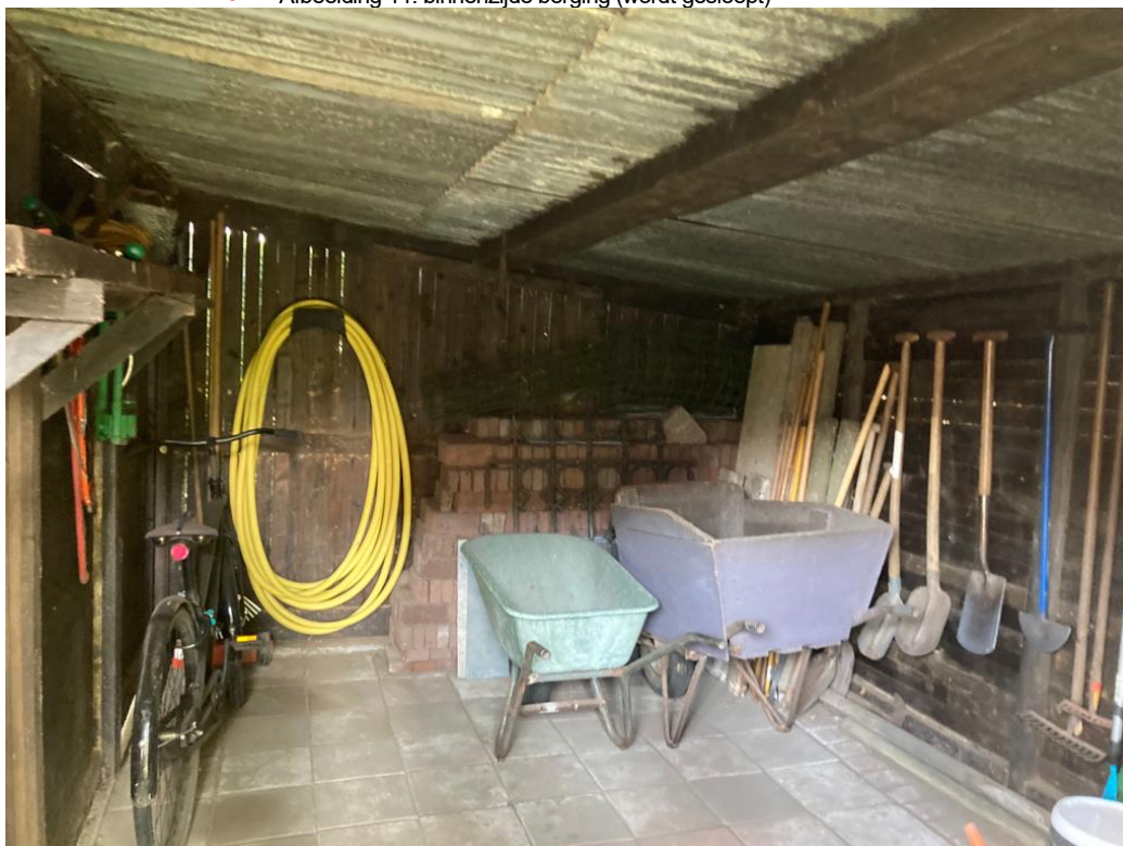
• Afbeelding 11: binnenzijde berging (wordt gesloopt)
